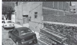
OBSTRUCCIÓN POR ESCALERAS
